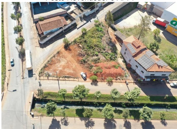
Figura 08: Vista área de onde será a instalação do Posto Revendedor e APP.
