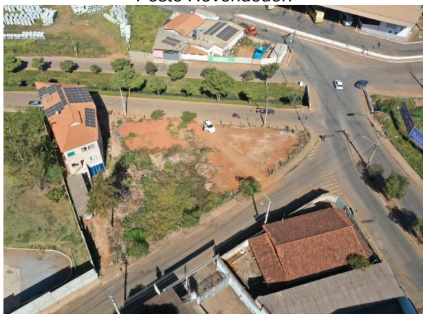
Figura 04: Vista área de onde será a instalação do Posto Revendedor.
